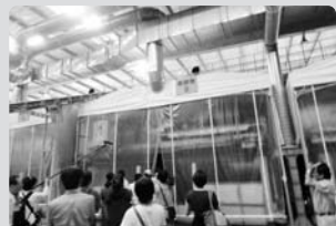
◎八王子バイオマス・エコセンターの住民説明会に参加 悪臭の原因となった発酵施設
